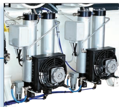
Die verbauten Absorptionstrockner haben keine Spülluftverluste, somit sind sie äußerst effizient und garantieren trockene Luft
