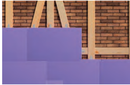
Druckfeste Dämmstoffplatten auf Holzunterkonstruktionen
