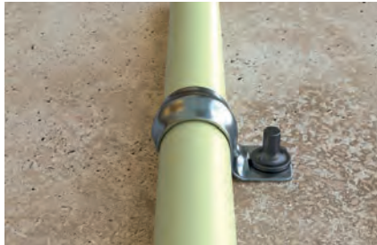
Befestigung von Panzerrohren
