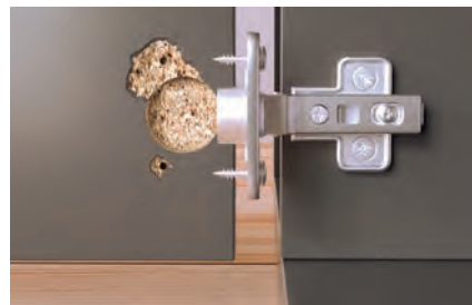
Reparatur ausgerissener Scharniere
