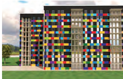
Sanierung von Wetterschalen
