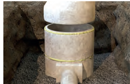
Abdichten von Beton-Schachtringen
