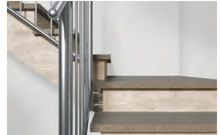
Treppenstufen auf Beton-Treppenwangen
