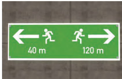
Fluchwegschilder im Tunnel
