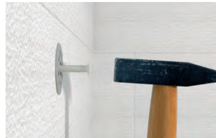
Geschlagener Dübel auf Polystyrol-Hartschaumplatte
