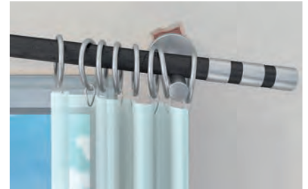
Reparatur ausgerissener Bohrlöcher
