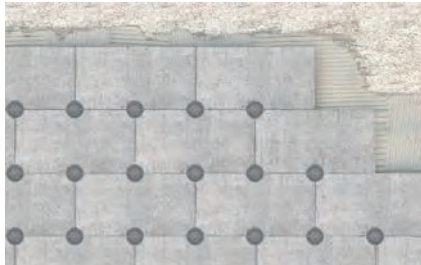
Oberflächenbündige Montage von Holzfaserplatten auf Holzkonstruktionen
