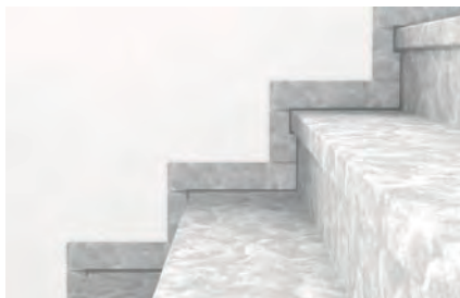
Verfugungen an Natursteinplatten
