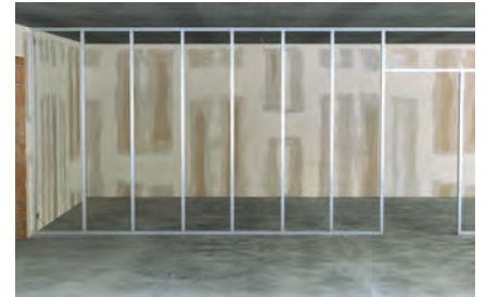
Ständerwände im Trockenbau
