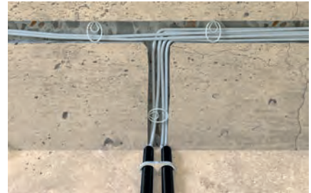
Kabelbefestigung in Wandschlitzten < 55 mm
