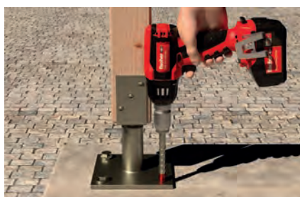
Montage von Stützenfüßen
