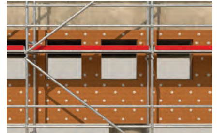
Druckfeste Dämmstoffe in vorgehängter Fassade
