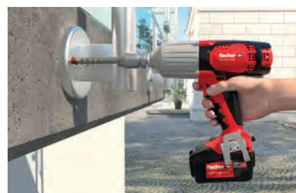
Installation von Balkongeländern
