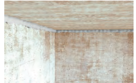
Schließen von Fugen im Rohbau
