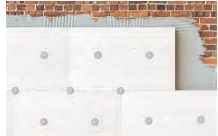
Polystyrol Hartschaumplatte 035 auf Kalksandlochstein
