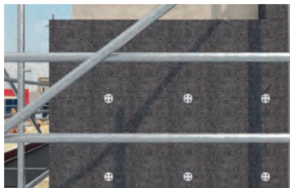
Druckfeste Dämmstoffe für Putzfassaden
