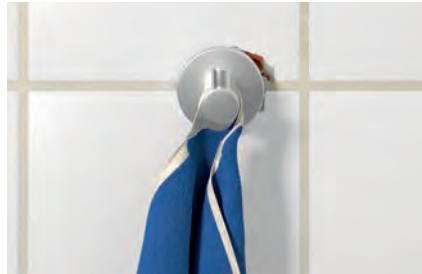
Reparatur ausgerissener Bohrlöcher
