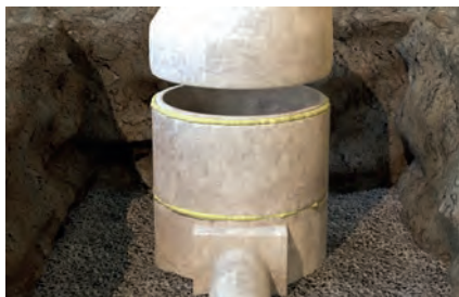
Abdichten von Beton-Schachtringen
