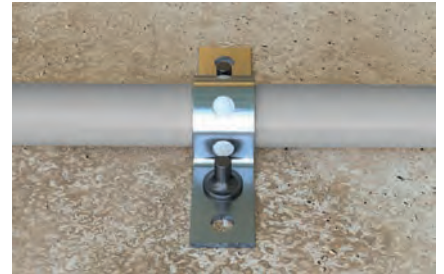
Befestigung von Lochbändern
