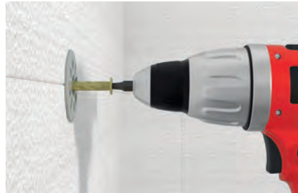
Geschraubte Befestigung von Dämmstoffplatten
