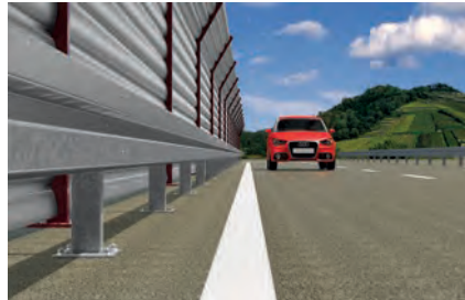
Leitplanken und Lärmschutzwände
