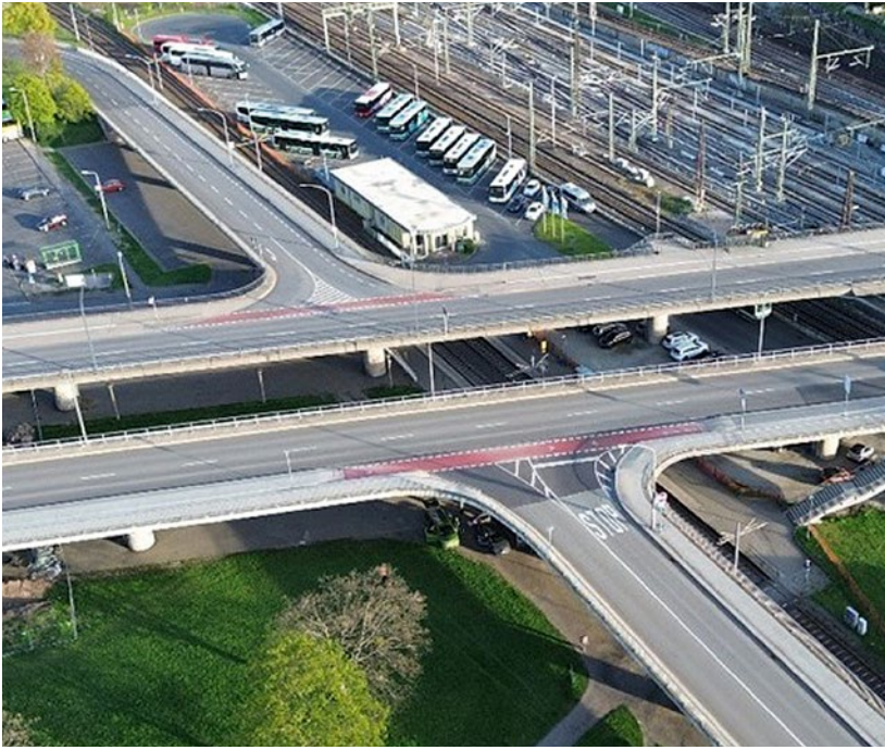
Stabile Wege: Akustiksensoren können die Bauten günstig überwachen.
